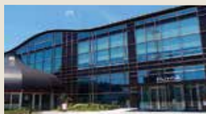
みんなの森 ぎふメディアコスモス 外観。平成27年7月に開館。 1階 市民活動交流センター 展示ギャラリー等 図書館の本の蔵(開放書庫) 2階 市立中央図書館
