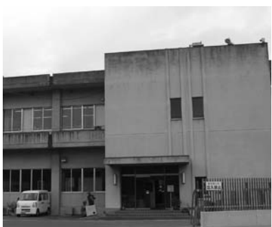
▲本市には中央・六尾の2つの浄水場があり、水道料金が高くなる原因のひとつとなっている。写真は六尾浄水場
