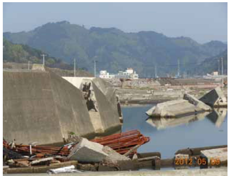
安渡地区（防潮堤付近の被災状況）
