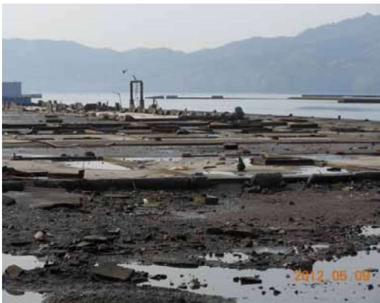
安渡地区（漁港付近の被災状況）
