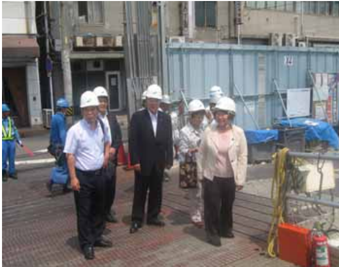
駅前ビル建設現場視察
