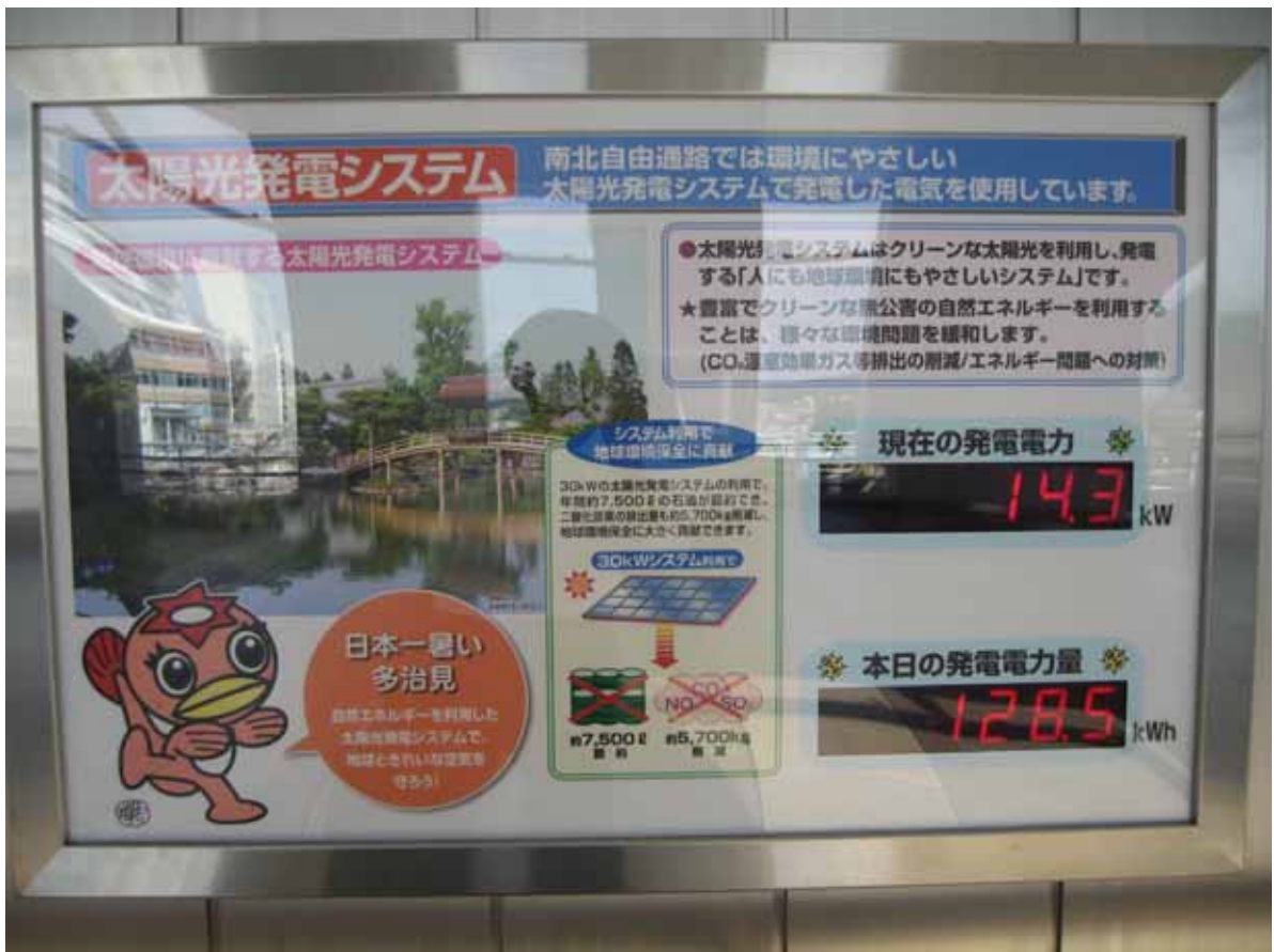
発電電力メーター
