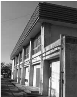
耐震化工事が始まる新家小学校体育館
