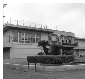
大規模改造工事が行われる鳴滝第二小学校
