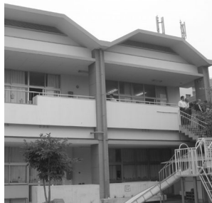
耐震化工事が始まる樽井保育所
